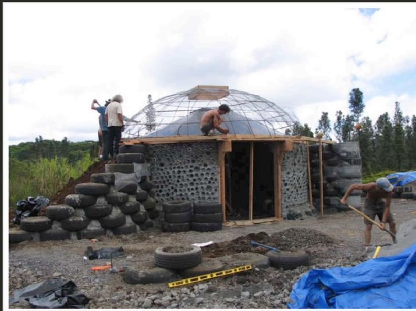
La seconda componente dell'edificio principale di una Earthship sono le lattine di alluminio. Le lattine sono utilizzati per costruire le pareti interne, non strutturali.
