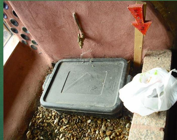
Primo filtraggio: fanghi attivi per la rimozione di sostanze nocive alle piante
